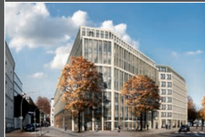
Lift shaft smoke extraction Kontorhaus Alsterufer 1–3, Hamburg, Germany 26
